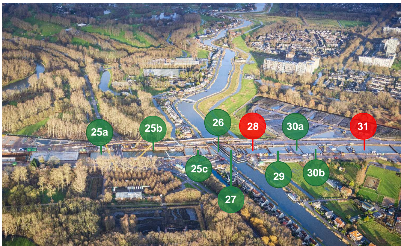
Afbeelding: overzicht bouwkuipen rondom Rottekeade. De onderwaterbetonvloer van bouwkuip 31 wordt als eerste uitgevoerd, gevolgd door bouwkuip 28.
