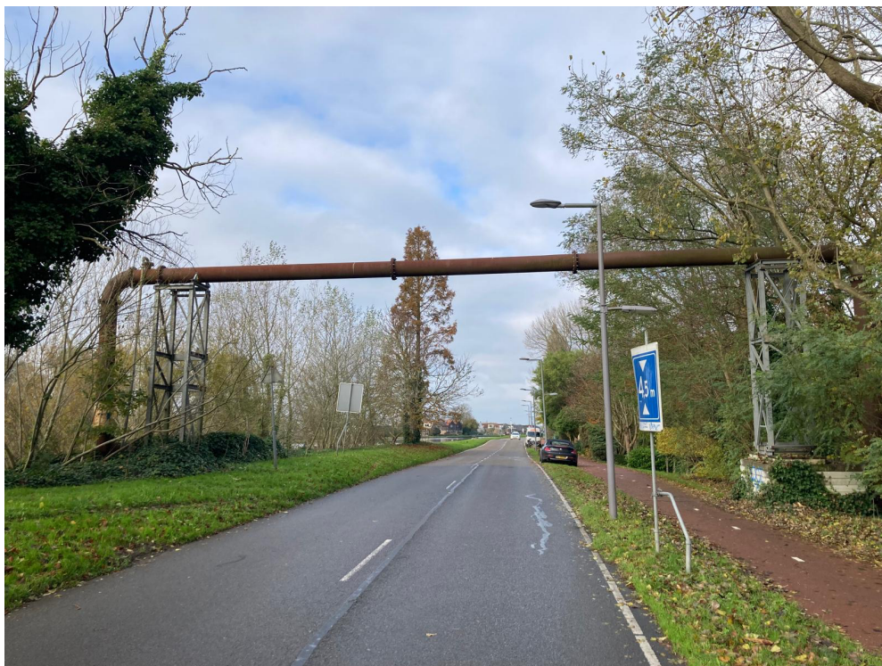
Zijaanzicht tijdelijke persleiding boven de Delftweg
